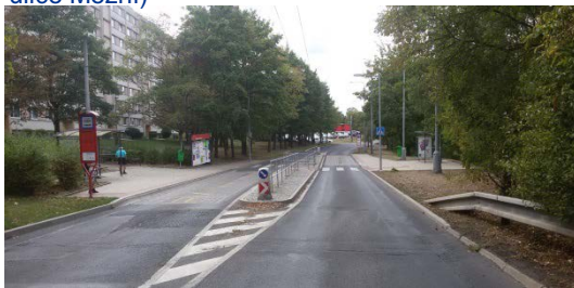
Trolejbusová zastávka typu zátka (zast. Větrná, ulice Mezní)
