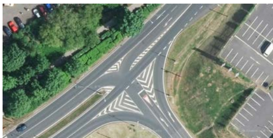
Křižovatka ulic Krušnohorská a Hoření
